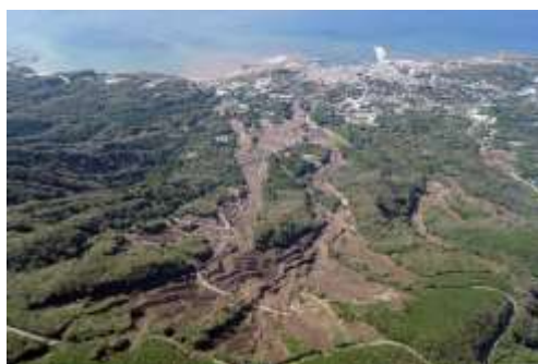
2013年台風26号による伊豆大島の被害 (Google)
